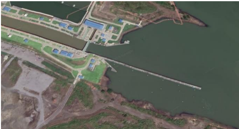
Figuur 4.2: Voorbeeld van een geleidingssysteem (op de foto : sluis Cocoli, Panama)
